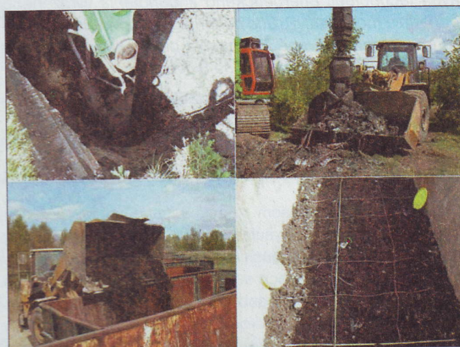
Obr. 1: b) Sitovanie vyťaženého odpadu [8]
