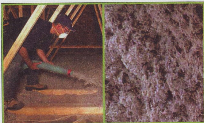
Obr. 3: Izolácia z celulózy podľa patentu US7758719B2
